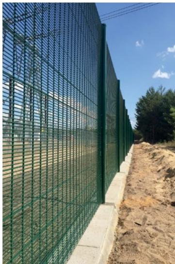
DeFence Line ONE SR1 (A1) - minimale verteringstijd 1 min.
